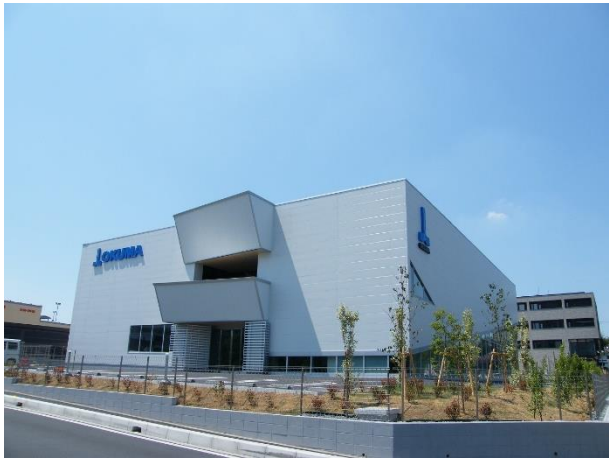
東日本支店 建屋外観（南側）
