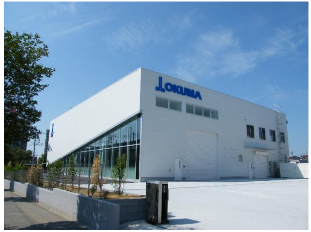
東日本支店 建屋外観（北側）
