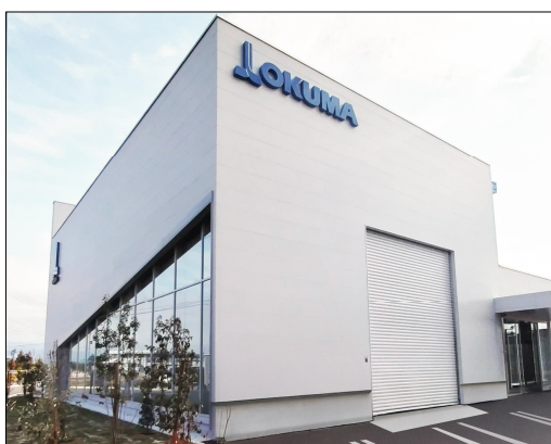
九州 CS センター 建屋外観
